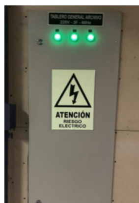
Mantenimiento de redes eléctricas:
